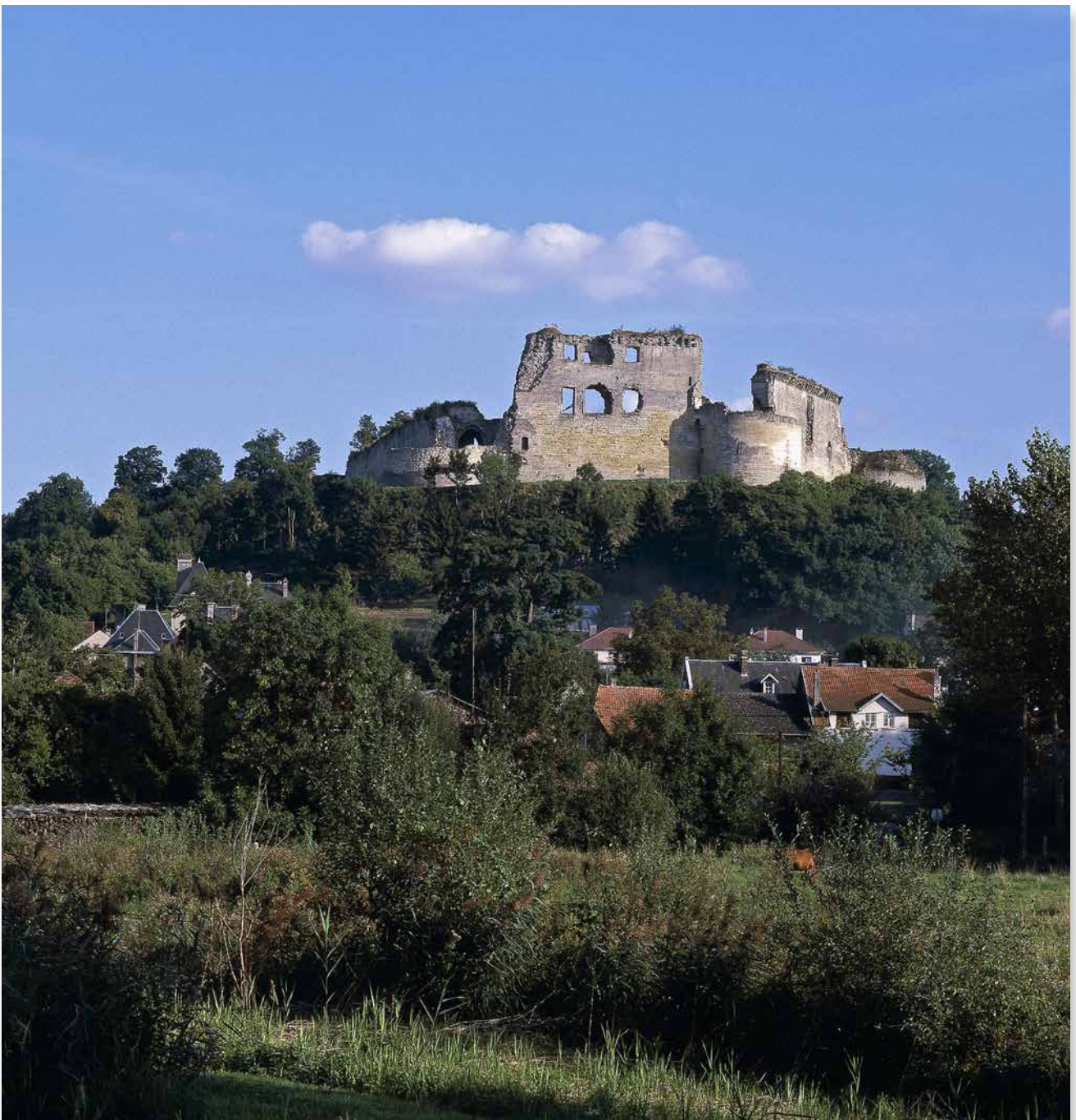
Ruines du château de Coucy, côté nord/nord-ouest, façade extérieure avec les fenêtres de la salle des Preuses et de la chambre de parement.
