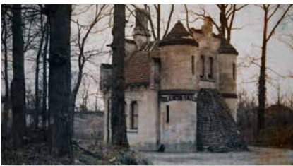
Maison du gardien du château au XIX e siècle avant sa destruction
